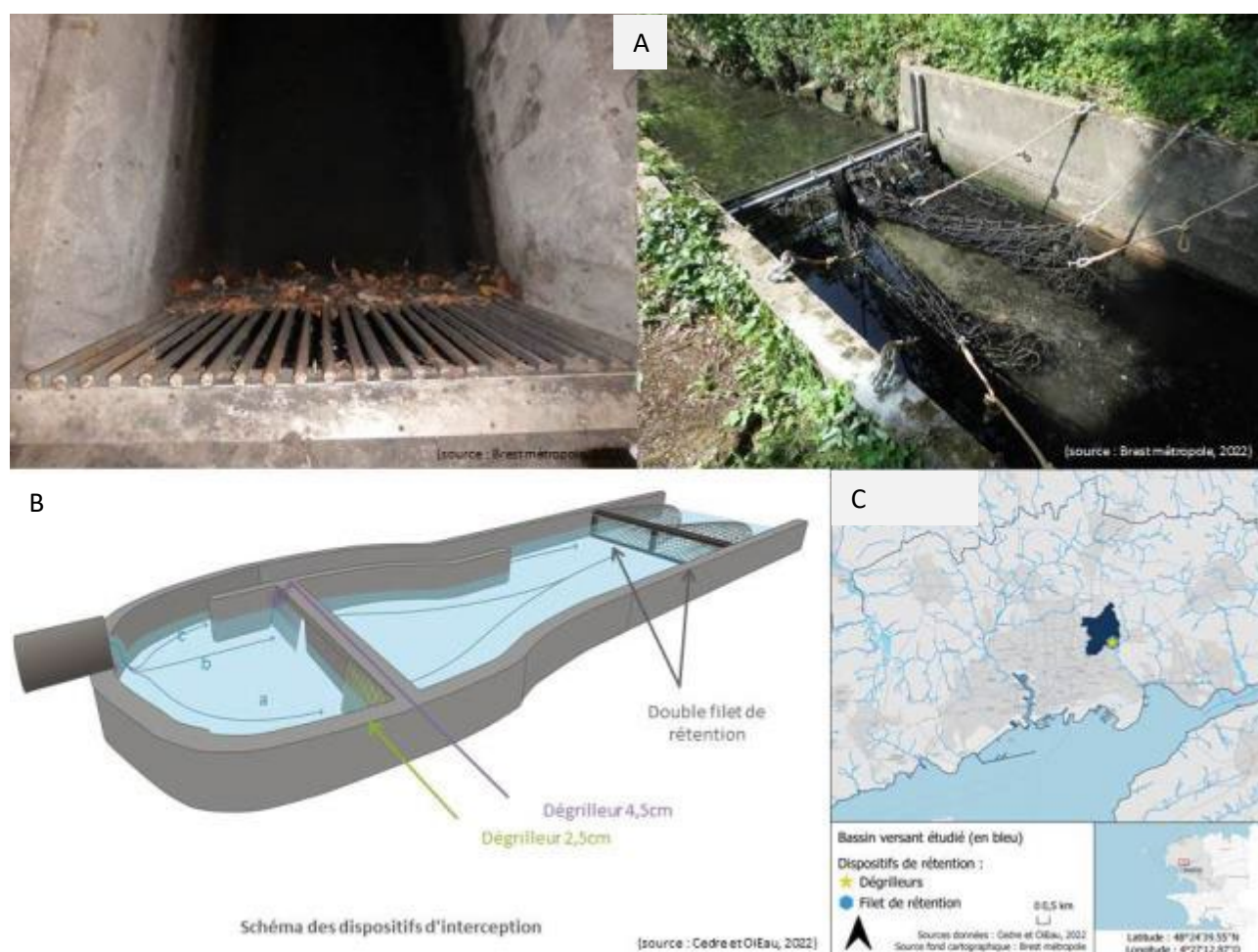
Figure 9 : Dispositifs de rétention étudiés sur le bassin versant du Stang Alar : (A) Photos des dispositifs : dégrilleur (à gauche) et filet de rétention (à droite), (B) Schéma de fonctionnement et lien entre les dispositifs étudiés, les flèches bleues indiquent le sens du flux d'eau et (C) Localisation du bassin versant (Source : Cedre)
