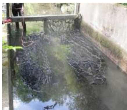
Remise en place du filet
