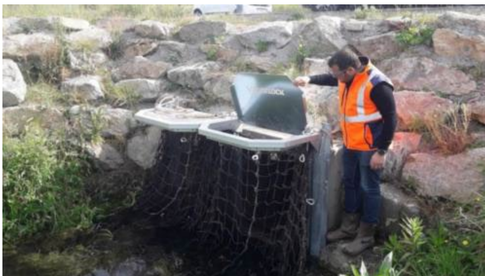
Figure 61 : Système de surverse installé sur le filet de rétention du Spernot (Source : Brest métropole)
