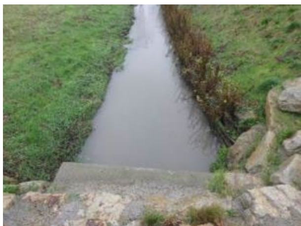
Figure 63 : Erosion de la berge naturelle du Spernot (perte de près de 20cm en 1 an) (Source : Brest métropole)
