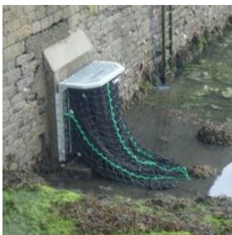
Figure 70 : Système de surverse installé sur le filet de rétention du Port de commerce (Source : Brest métropole)
