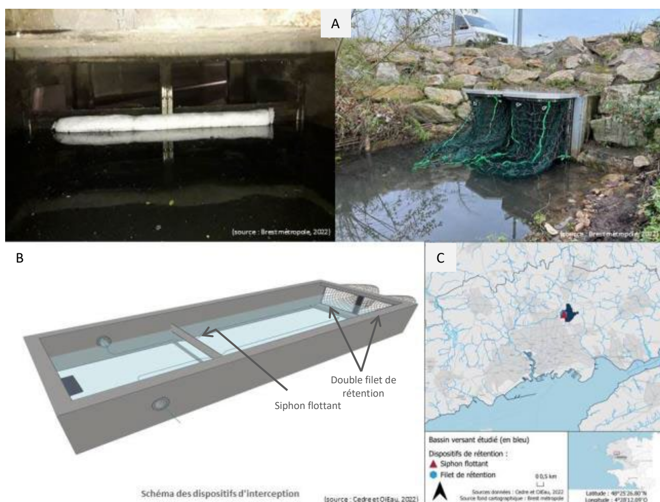
Figure 10 : Dispositifs de rétention étudiés sur le bassin versant du Spernot : (A) Photos des dispositifs : siphon flottant (à gauche) et filet de rétention (à droite), (B) Schéma de fonctionnement et lien entre les dispositifs étudiés, les flèches bleues indiquent le sens du flux d'eau et (C) Localisation du bassin versant (Source : Cedre)
