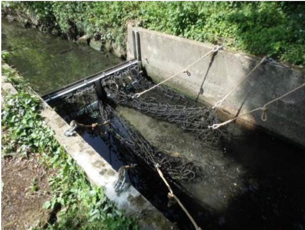
Figure 55 : Abaissements des cadres retenant les filets au Stang-Alar (Source : Brest métropole)
